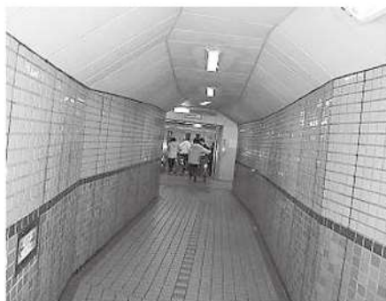
■安治川トンネル
