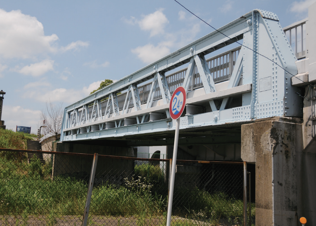
わが国最初の鉄道橋に用いられた主桁。上流側よりも斜材断面が大きい
