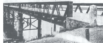
本橋と同じように鉄道用ワーレントラス桁を道路橋に転用した1909(明治42)年5月完成の長柄橋(出典「大阪の橋」、原典は「西成郡史」)
