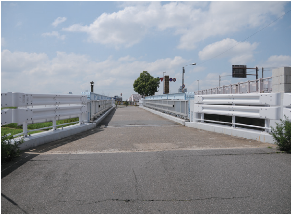
浜中津橋正面。車2台がすれ違える幅はないが、十三小橋の時には一日に車両5500台、自転車8000台、歩行者6000人の通行を支えた
