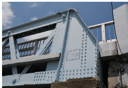
橋長を延ばすために追加された継足部
