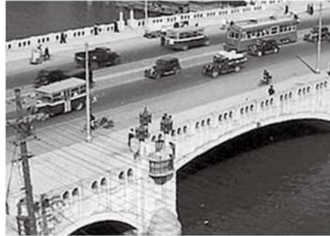
完成直後の大江橋
