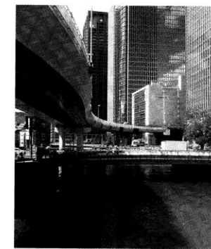
写真-4 肥後橋を横断して土佐堀川と交差する中之島S字橋
