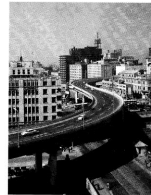
写真-2 供用された間もない中之島S字橋。当初は南行きの方通行でした
